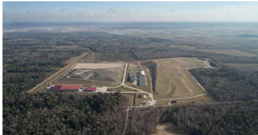
23 pav. Panevėžio regioninis sąvartynas
