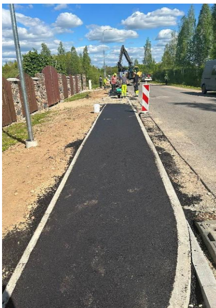
Pėsčiųjų tako asfaltavimo darbai Rokiškio m. Alvydo Matulkos g.
